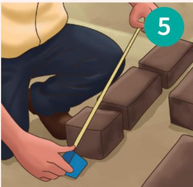
Las medidas de la cámara de combustión deben ser de 20 cm de ancho × 40 cm de profundidad × 20 cm de alto.
